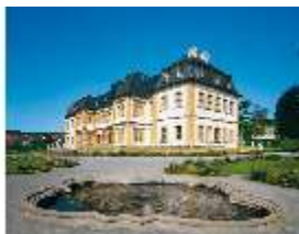
Vh.I, Westfassade, DE001540, BSV-
