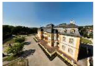
Vh.I, Westfassade, Schloss, Luftaufnahme von Süd/West, DI027521, BSV-
