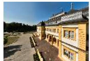
Vh.I, Westfassade, Schloss, Luftaufnahme von Süd/West, DI027522, BSV-
