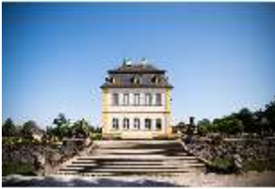
Vh.I, Südfassade und Südliche Treppenanlage, Schloss, DI027545, BSV-
