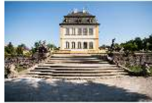
Vh.I, Südfassade und Südliche Treppenanlage, Schloss, DI027556, BSV-
