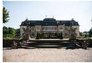
Vh.I, Westfassade und Westliche Treppenanlage, Schloss, DI027593, BSV-
